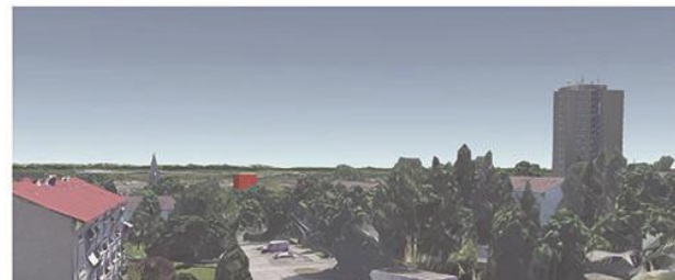
Blick von Norden
